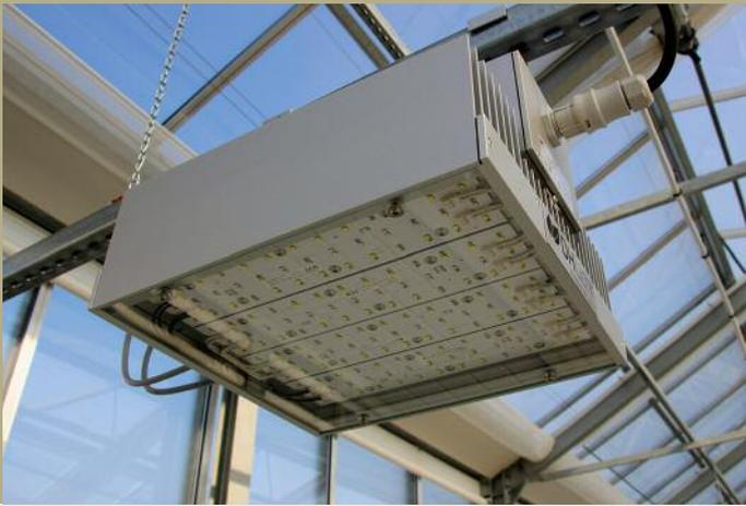
LED-System: Fraunhofer-Forschende untersuchen u. a. den Einfluss von Beleuchtungsszenarien auf Pflanzenwachstum und -qualität.
